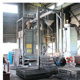
本社 本社設備
