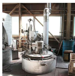
田尻工場 ピット型ユニゾフ炉
